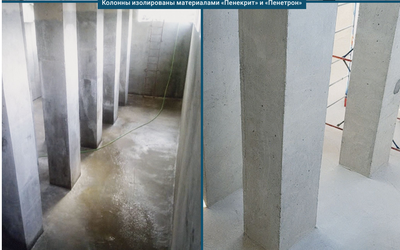
Колонны изолированы материалами «Пенекрит» и «Пенетрон»
