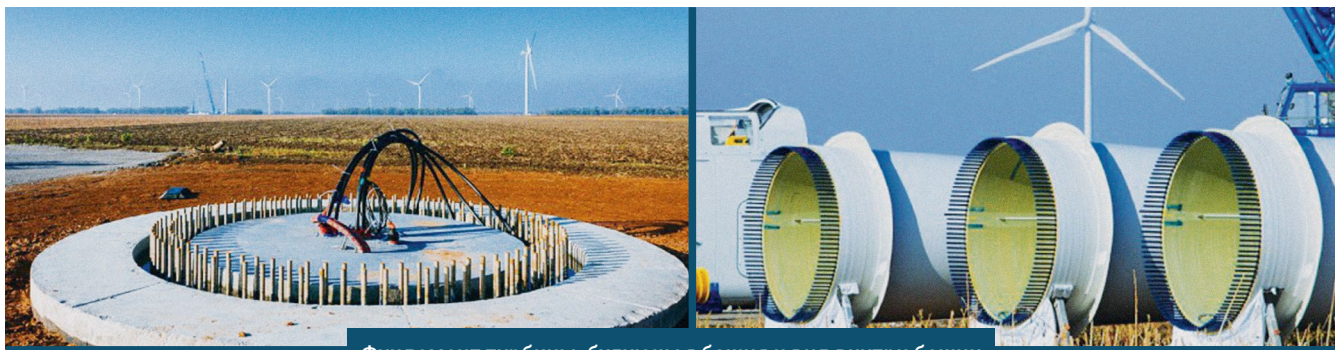
Фундамент турбины, будущая башня и вид внутри башни
