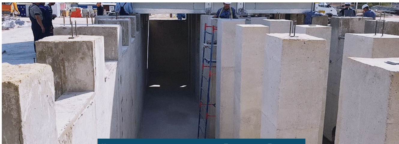
Колонны изолированы материалами «Пенекрит» и «Пенетрон»
